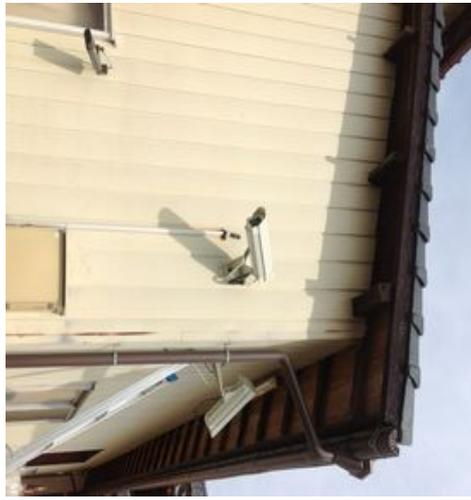
主に駐車場や倉庫・マンションに設置する威嚇的な望遠監視カメラです。筒状の内部に望遠レンズを内蔵したり、赤外線LEDを発光させたり色々な屋外用カメラがあります。ハウジングの中に排気ファンが付いていてカメラレンズが曇らないタイプ・寒冷地でレンズに結露が付かないようにヒーターが付くタイプもあり多種多様です。
